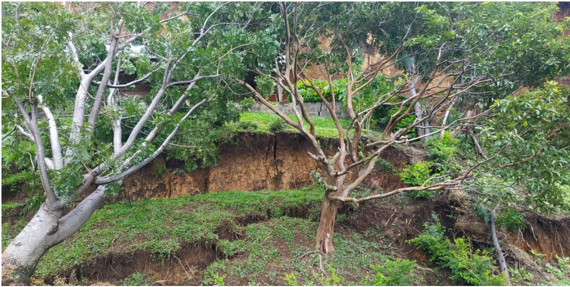
Fotografía N°5. Bloques de suelo orgánico superficial de gran tamaño. Fuente propia.
