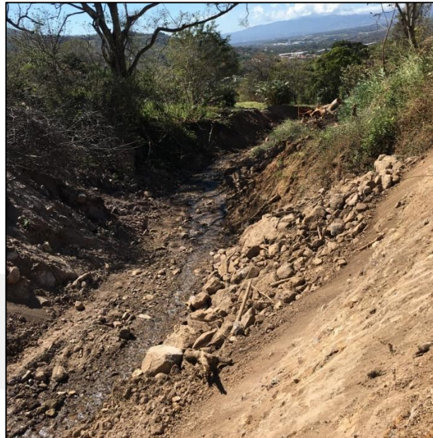
Fotografía N° 5. Tramo del cauce del Río Corrogres: Fuente: propia.
