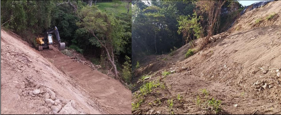
Fotografía N° 11. Proceso de terraceo realizado por la Municipalidad de Santa Ana en la zona del deslizamiento, tomado de Masis (2015a).
