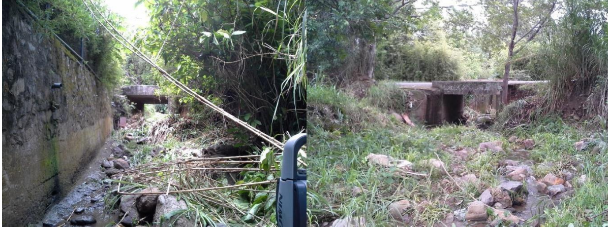
Fotografía N° 17. puente 1 visto desde aguas abajo y aguas arriba, nótese la depositación de detritos antiguos del lado aguas arriba, tomadas de Masis (2015b).
