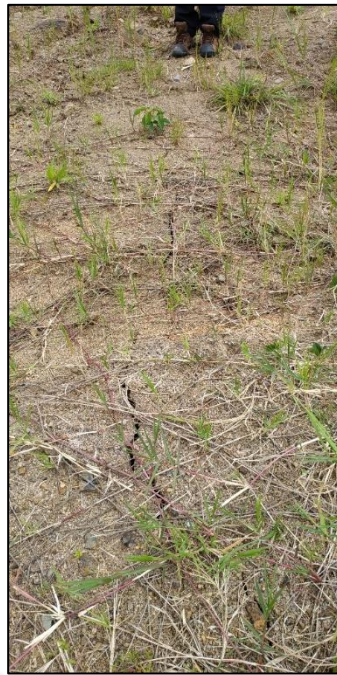
Fotografía N° 22. Grieta observada el 12 de octubre del año 2020. Fuente: Propia.
