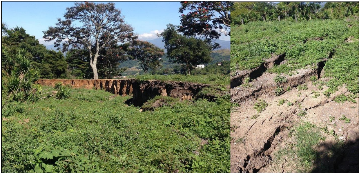
Fotografía N° 6. Zona del deslizamiento, noviembre del 2014, tomado de Masís (2015a).
