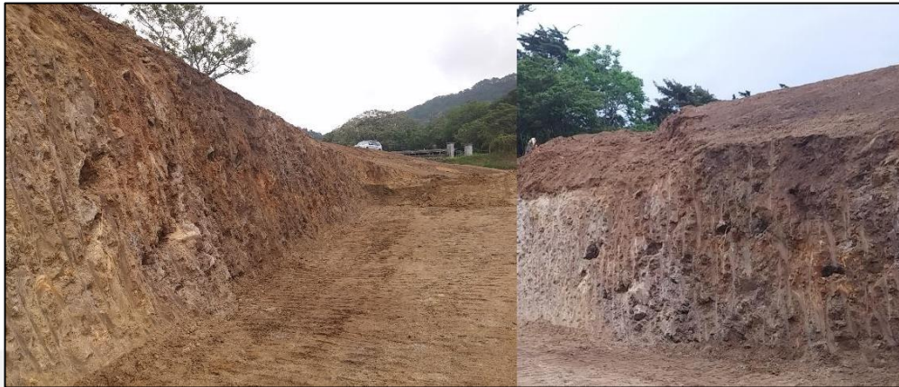
Fotografía N° 10. Proceso de terraceo realizado por la Municipalidad de Santa Ana en la zona del deslizamiento, tomado de Masis (2015a).
