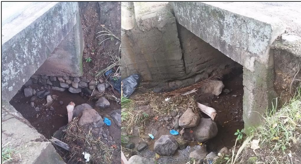
Fotografía N° 18. Entrada al puente 1 de limitada capacidad hidráulica, nótese la degradación socavación del lecho por contracción de la sección, tomadas de Masis (2015b).
