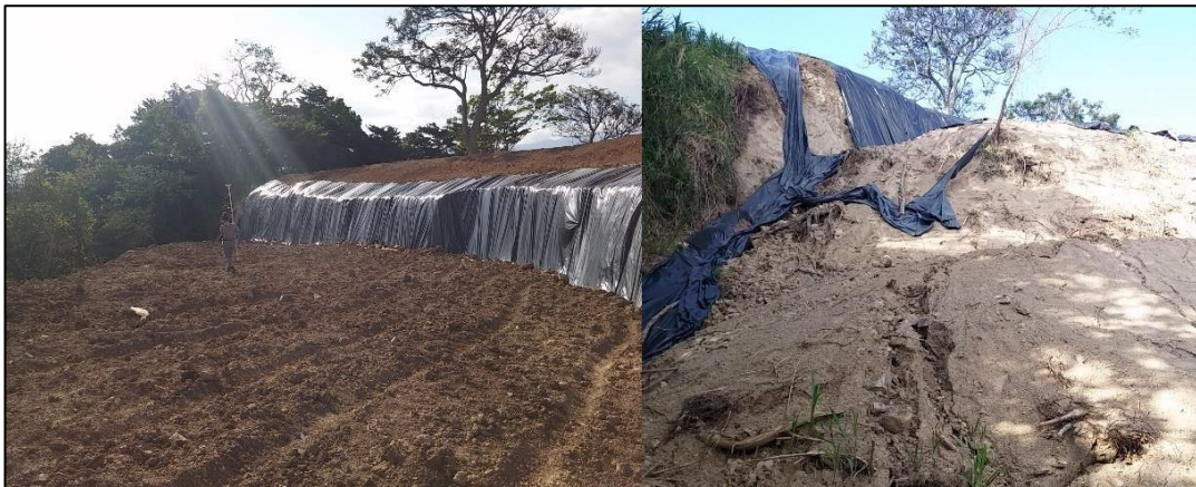
Fotografía N° 12. Proceso de terraceo realizado por la Municipalidad de Santa Ana en la zona del deslizamiento, tomado de Masis (2015a).
