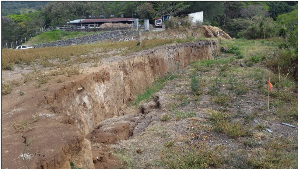
Fotografía N° 9. Vista de las grietas generadas, en dirección casi paralela al cauce, hacia el sureste, tomado de Masis (2015a).
