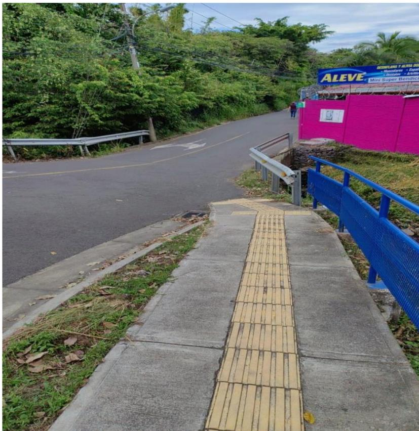
**Figura 2:** Estado de la superficie de ruedo Accesos de aproximación y tablero de alcantarilla
