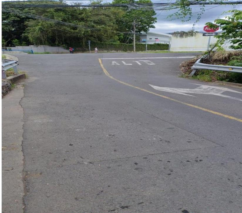
**Figura 3:** Superficie de ruedo con desgaste superficial
