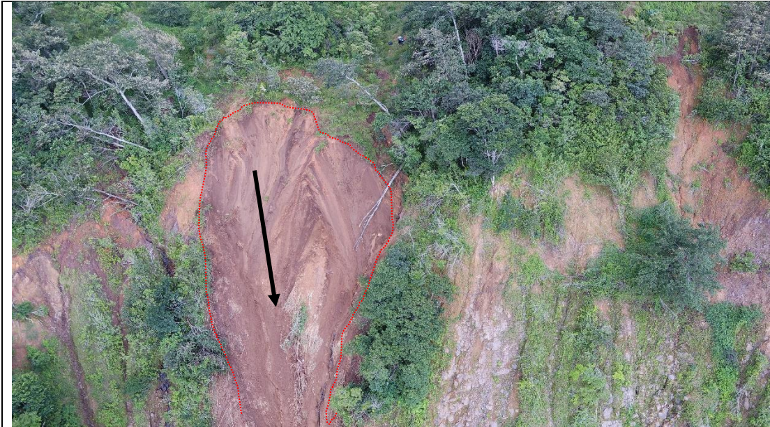
Figura 4: área reactivada con desprendimientos en el lóbulo frontal del deslizamiento Tapezco, sector Pittier.
