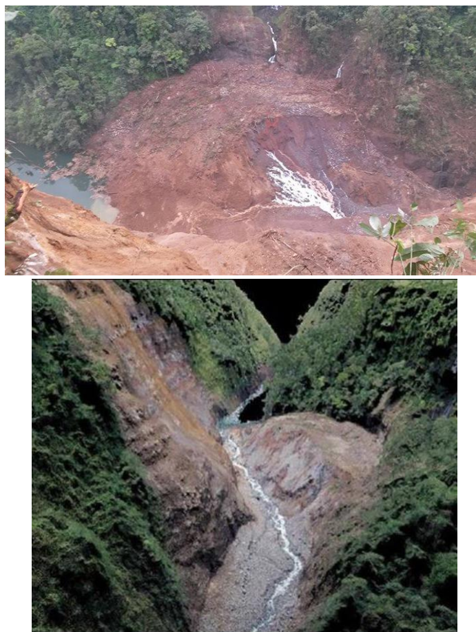
FOTOGRAFÍAS 6.1 Y 6.2. IZQUIERDA PROCESO DE COLAPSO POR TUBIFICACIÓN EN LA PRESA NATURAL. DERECHA: APERTURA DEL CANAL DE EROSIÓN POSTERIOR A LA FALLA POR TUBIFICACIÓN.
