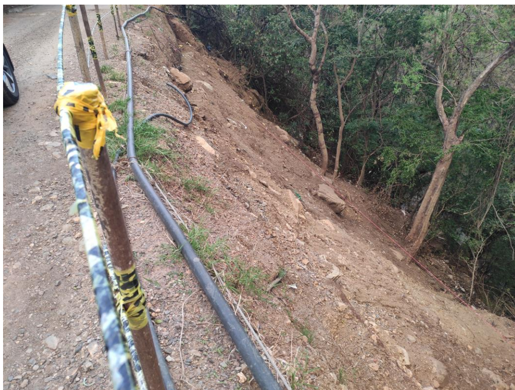
Figura 23. Condición del talud
