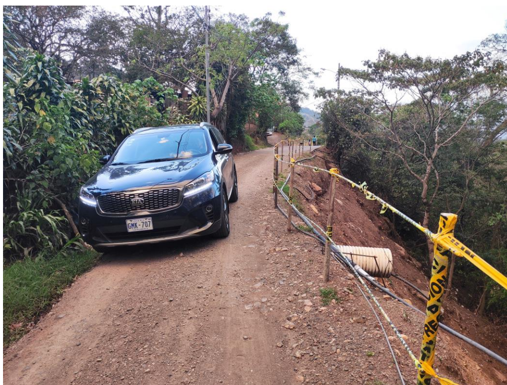
Figura 22. Imágenes del sitio desde la carretera
