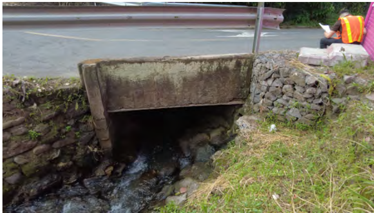
Figura 4.1: Alcantarilla a sustituir sobre la Calle Canelos
