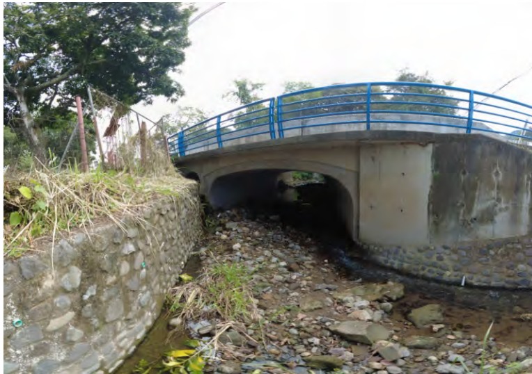
Figura 4.3: Alcantarilla tipo Conspam sobre la Ruta Nacional No. 121
