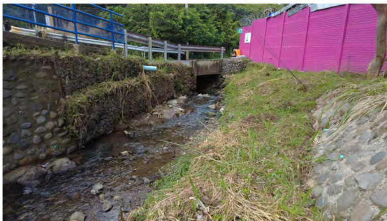
Figura 4.2: Alcantarilla a sustituir sobre la Calle Canelos
