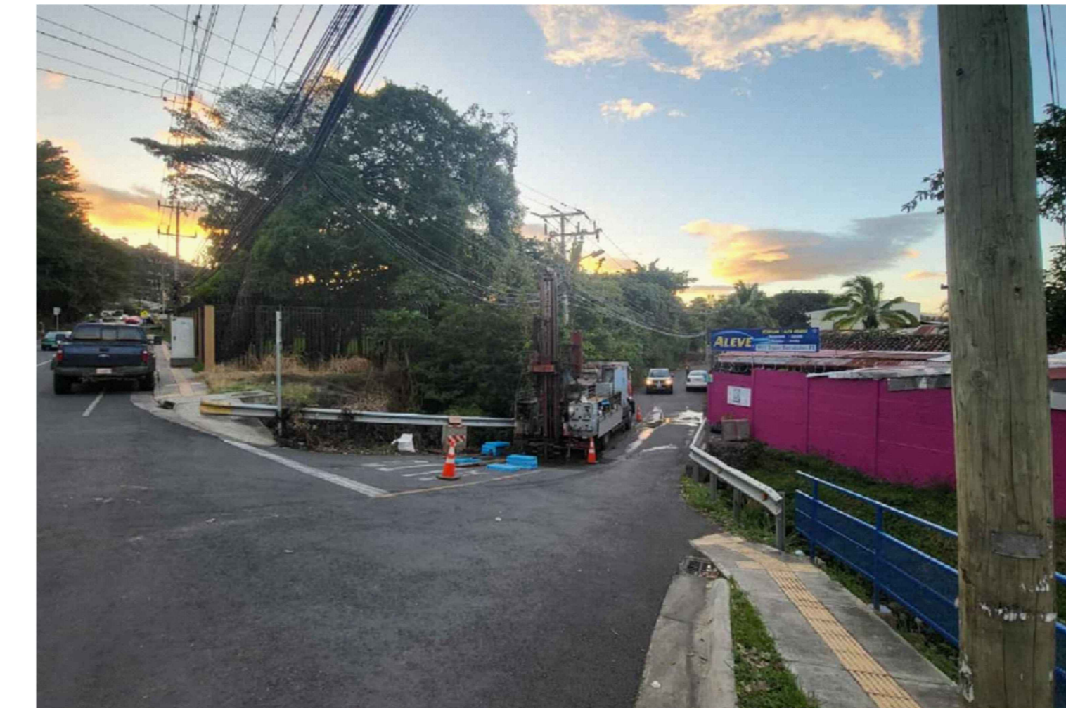
FOTOGRAFIA 1 (VISTA DEL PUENTE ACTUAL SOBRE QUEBRADA CARAÑA)
