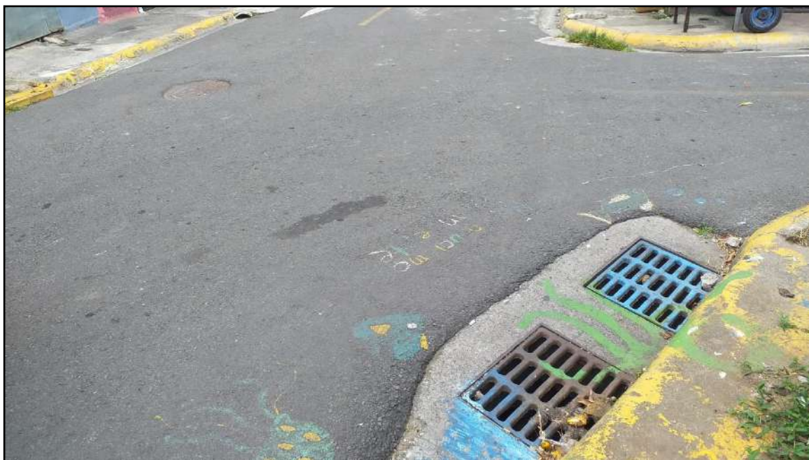
Fotografía N°21. Tragantes colectores sobre cunetas de evacuación pluvial. Coordenadas: 479160 E / 1101776 N proyección CRTM-05.
