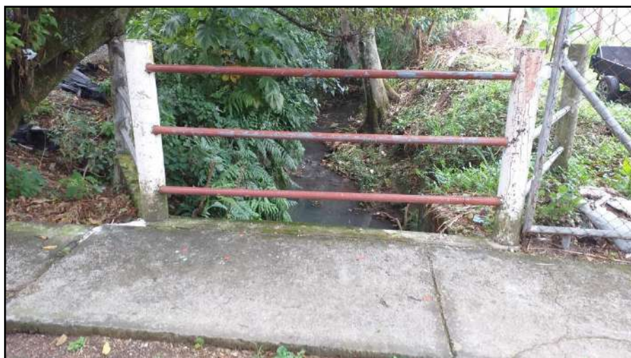
Fotografía N°7. Punto 2: sector bajo de la urbanización Bosques de Santa Ana sitio analizado por Hcanales. Coordenadas: 479102E /1101813N proyección CRTM-05.
