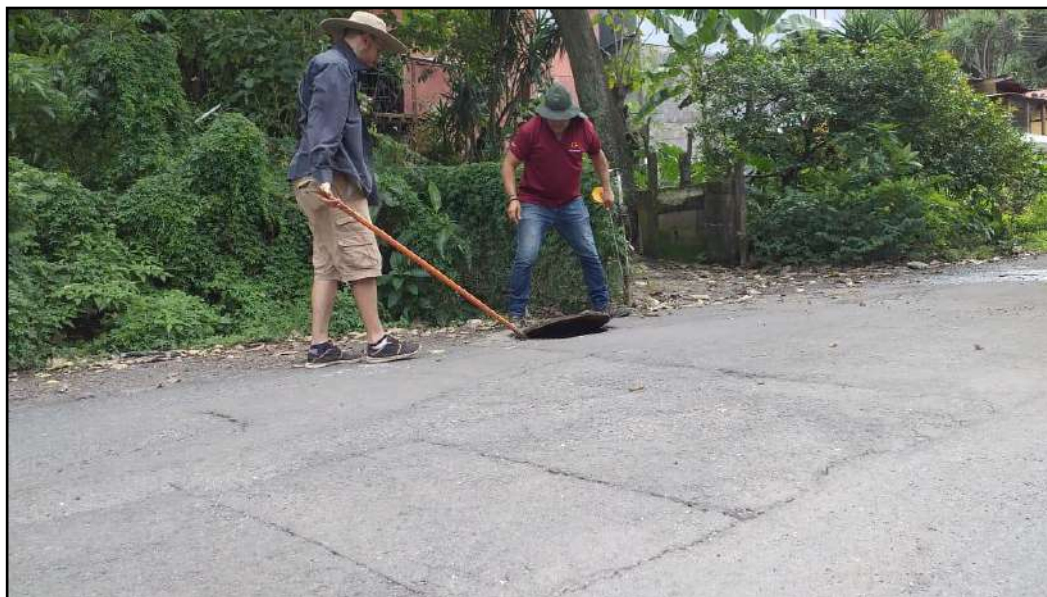
Fotografía N°17. Levantamiento de las condiciones actuales de la red pluvial sobre la urbanización Bosques de Santa Ana. Coordenadas: 479421E / 1101812N proyección CRTM-05.
