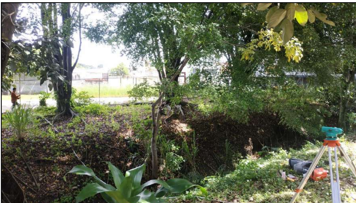
Fotografía N°13. Levantamiento topográfico del sector C-3 de la quebrada Pilas. Coordenadas: 479245E / 1101847N proyección CRTM-05.
