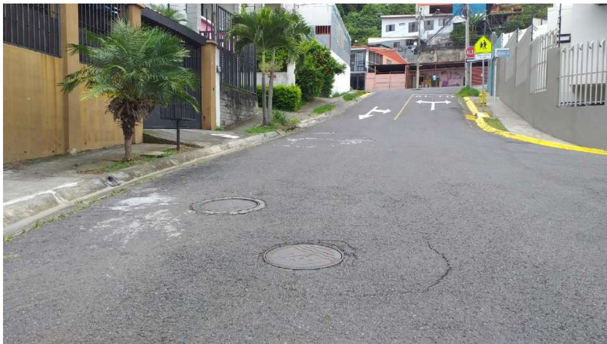
Fotografía N°30. Sector con problemáticas de inundación, en Calle 16: 479342 E /1101818 N proyección CRTM-05.
