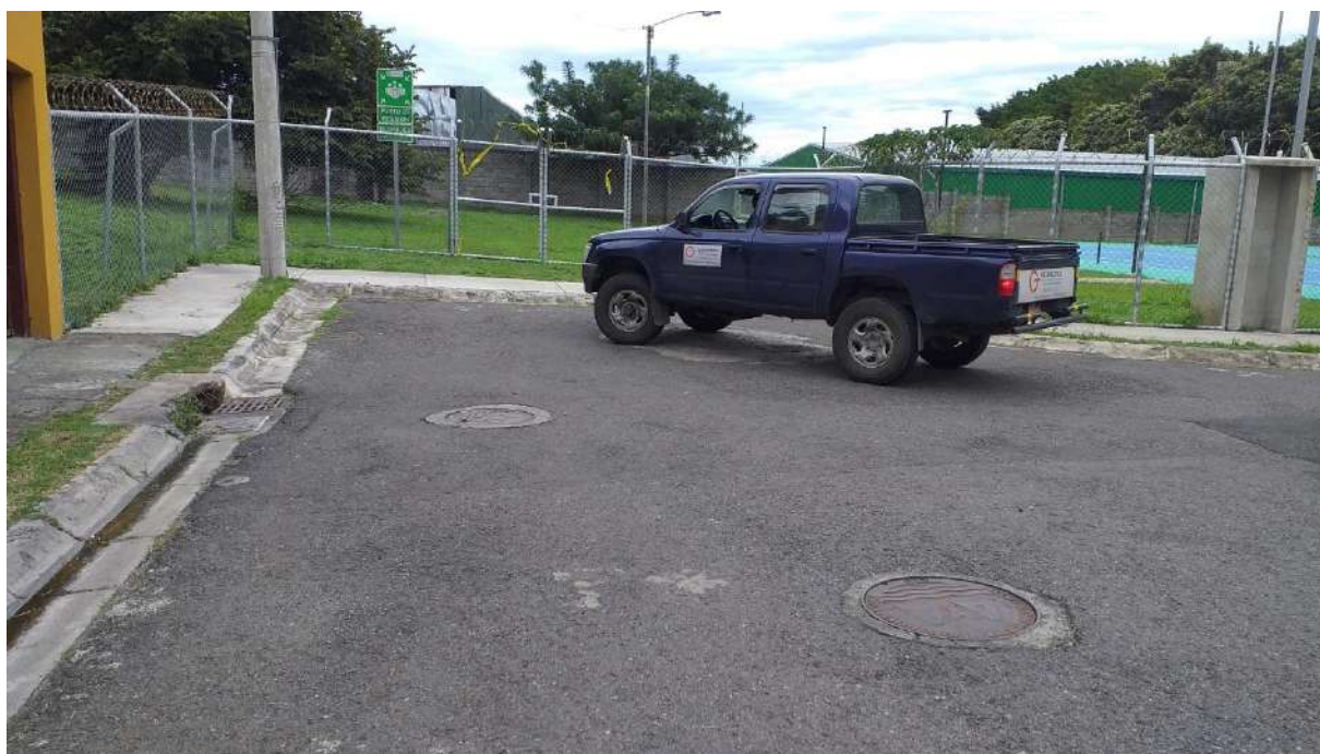
Fotografía N°31. Sector con problemáticas de inundación, colindante a la cancha de tenis, bloque M: 479302 E / 1101797 N proyección CRTM-05.
