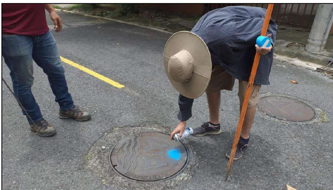
Fotografía N°19. Marcado de las tapas después de su levantamiento respectivo sobre la red pluvial. Coordenadas: 479216 E / 1102056 N proyección CRTM-05.
