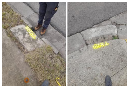
Ilustración 41: Tragantes sin acceso - 2
