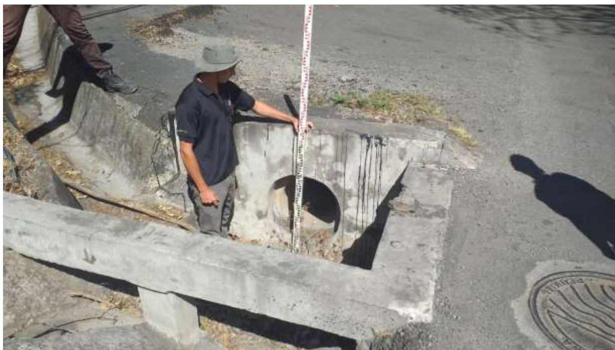
Fotografía N° 15. Caja pluvial donde tributan las aguas del plantel del AyA, mismas que se conectan al pozo pluvial que se observa en la Fotografía: 479822E /1097115N proyección CRTM-05.
