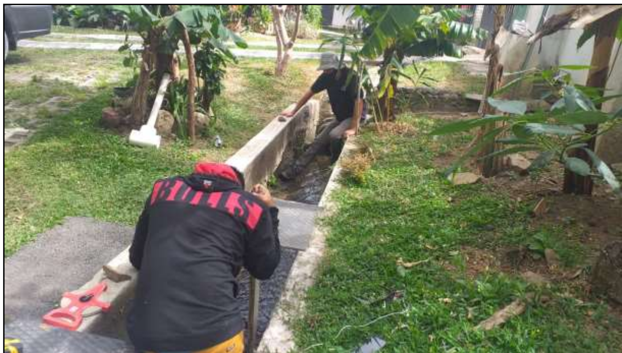
Fotografía N°1. Aforo 1, canal para transporte de concesión total. Coordinadas: 479860E /1097091N proyección CRTM-05.
