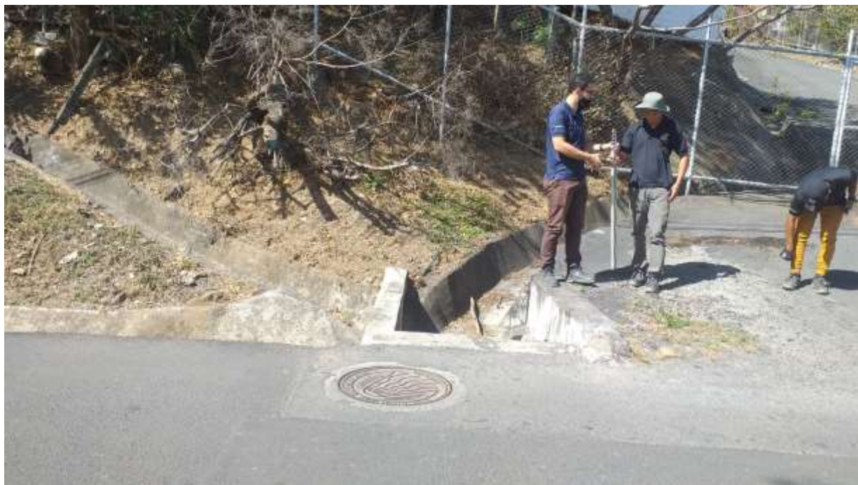
Fotografía N°14. Entrada a plantel del AyA, se aprecian los canales que llevan la escorrentía y el flujo del rebalse hasta el sistema pluvial: 479822E /1097115N proyección CRTM-05.
