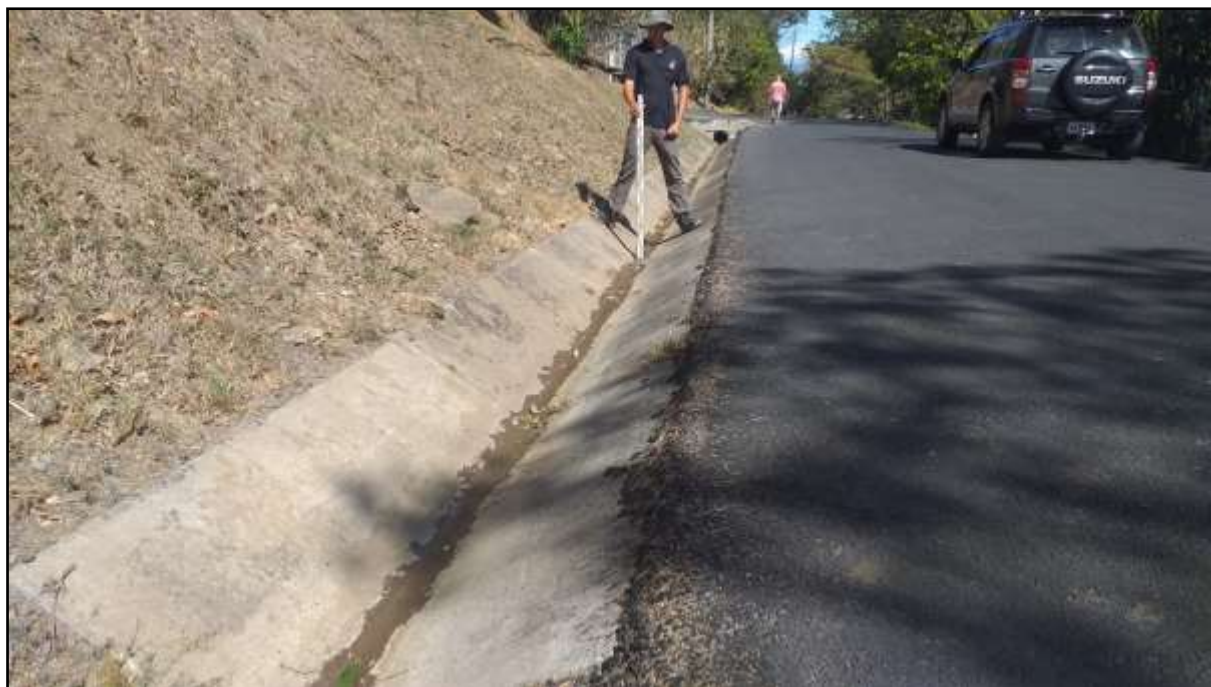
Fotografía N°6. Sector H2, canal trapezoidal colindante al plantel del AyA Coordenadas: 479860E / 1097093N proyección CRTM-05.
