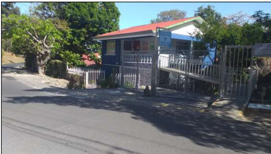
Fotografía N°10. Sector de la Clínica Drs Méndez, sitio con grandes problemáticas de inundación y flujo de lodos: 479883E /1097042N proyección CRTM-05.
