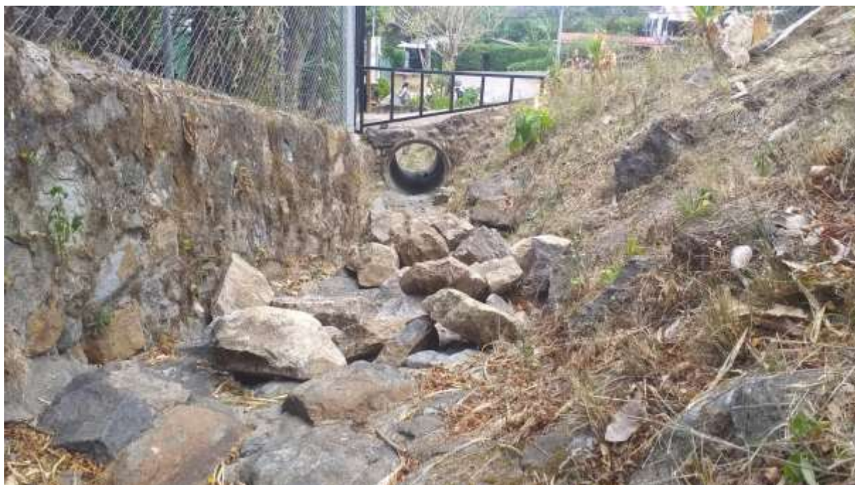
Fotografía N°19. Canal que lleva el agua hasta las estructuras que se observa en la fotografía anterior: 1097274 E / 479686 N proyección CRTM-05.
