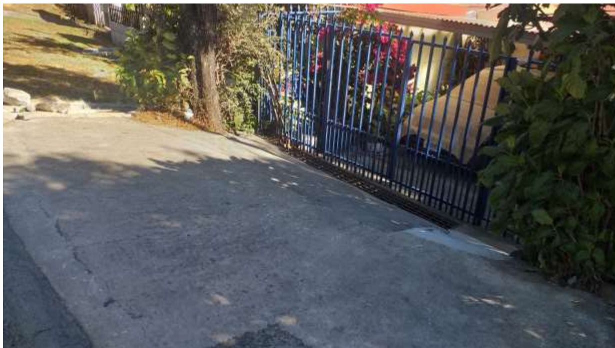
Fotografía N°12. Vivienda con alto potencial de inundación: 479862E /1097062N proyección CRTM-05.
