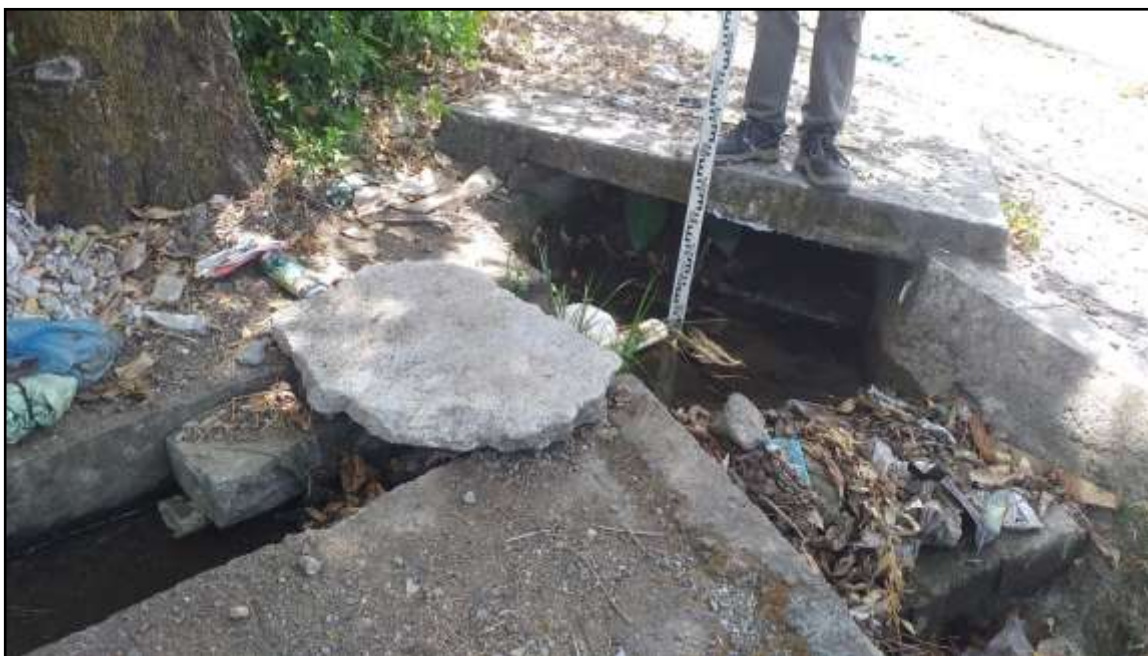
Fotografía N°3. Sector de desvío hacia cultivos. Coordenadas: 479705E /1097390N proyección CRTM-05.
