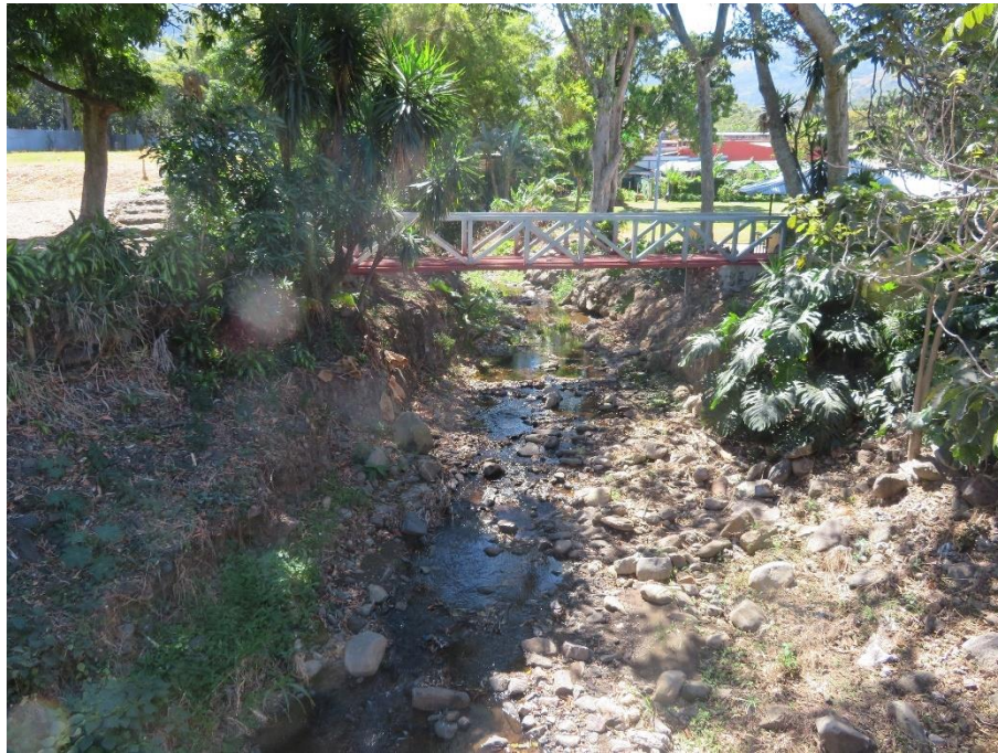
Figura 2.16. Condición del cauce del río Corrogres en el sitio del puente 5a
