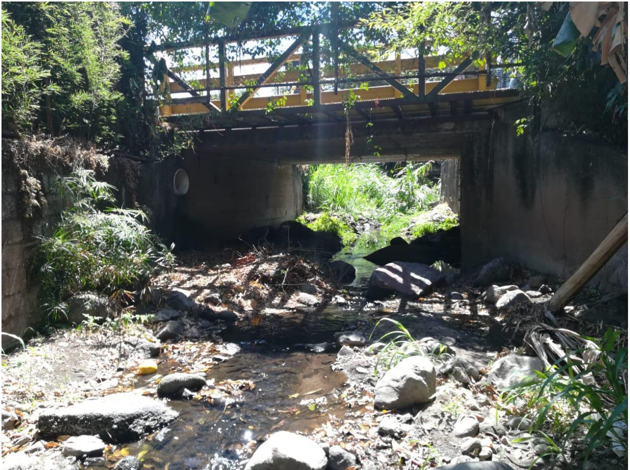
Figura 2.19. Puente 6, Paso Vehicular Avenida 0A
