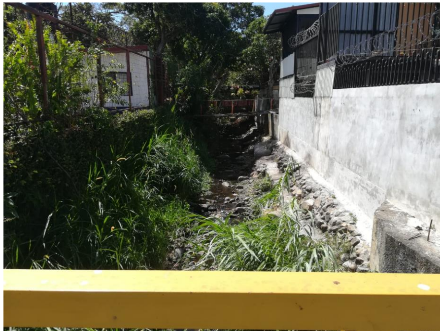
Figura 2.20. Condición del cauce del río Corrogres en el sitio del puente 6
