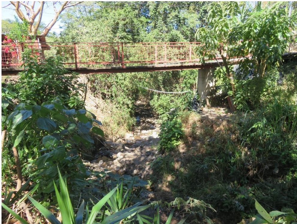
Figura 2.8. Puente 2, Paso Peatonal Los Arias
