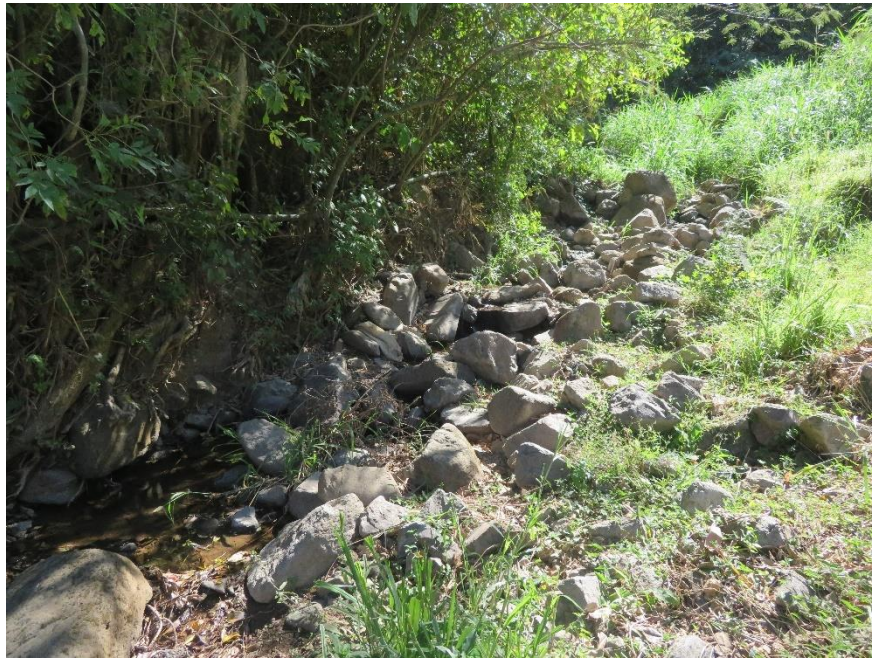
Figura 2.7. Condición del cauce del río Corrogres en el sitio del puente 1
