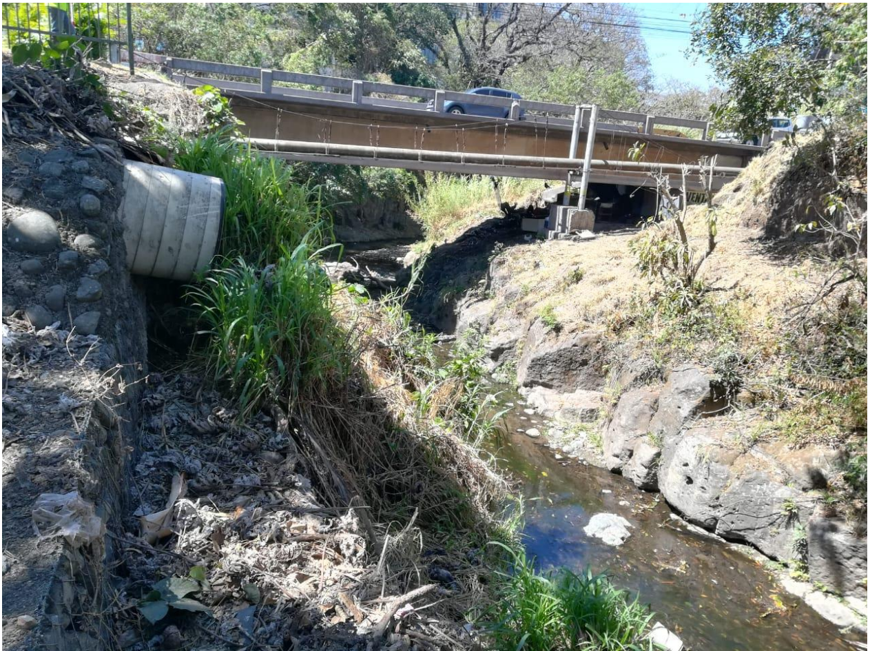
Figura 2.44. Puente 18, Paso vehicular sobre Radial Lindora
