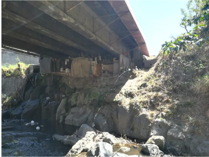
Figura 2.43 (cont.). Puente 18, Paso vehicular sobre Radial Lindora
