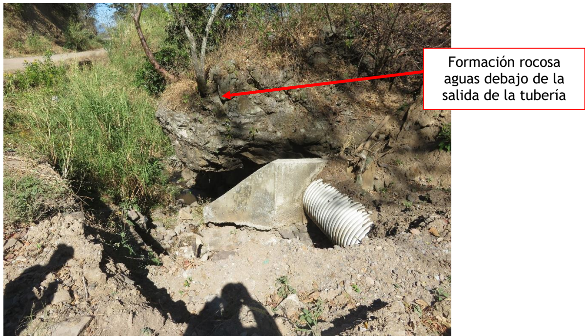
Figura 2.6. Alcantarilla Calle Chirracal
