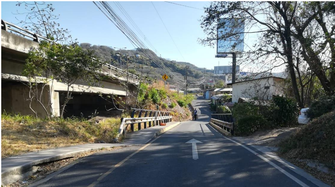
Figura 2.39. Puente 15, Paso vehicular calle marginal salida Ruta 27
