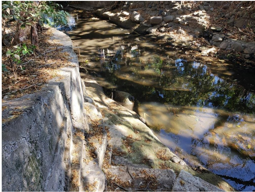
Figura 2.36. Condición del cauce del río Corrogres en el sitio del puente 13
