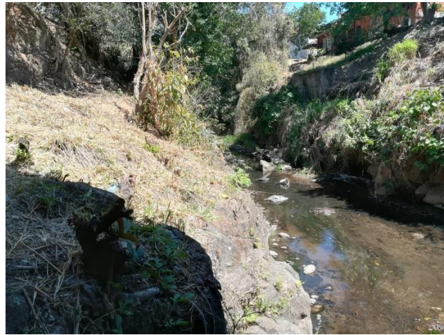
Figura 2.45. Condición del cauce del río Corrogres en el sitio del puente 18
