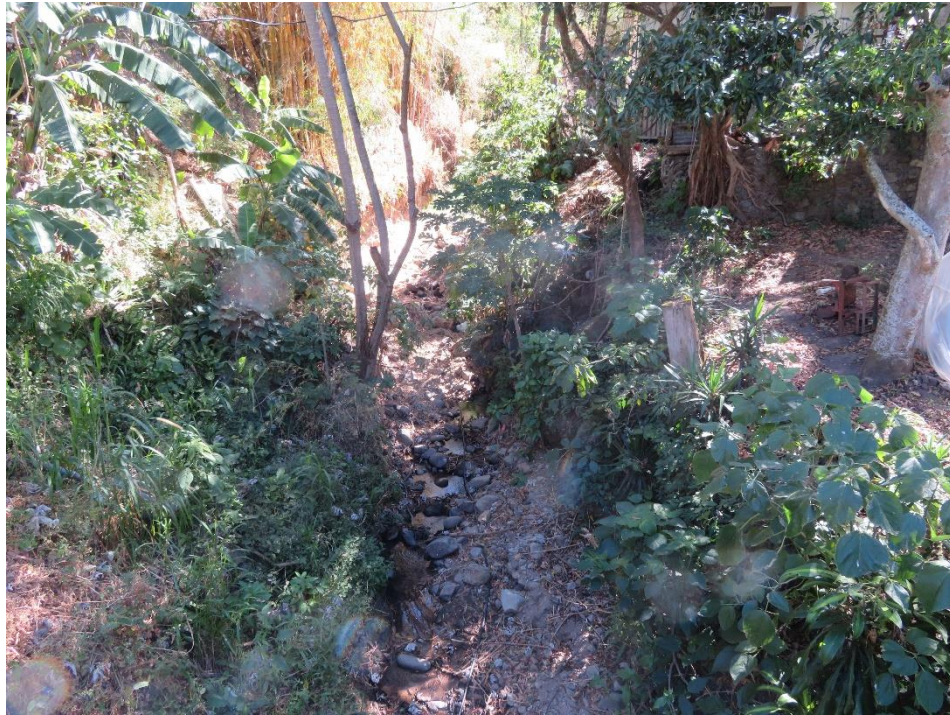
Figura 2.9. Condición del cauce del río Corrogres en el sitio del puente 2
