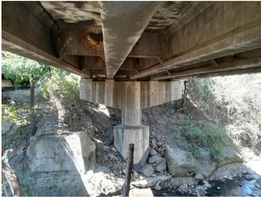
Figura 2.40 (cont.). Puente 16, Paso vehicular Ruta 27
