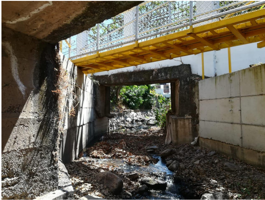
Figura 2.26. Condición del cauce del río Corrogres en el sitio del puente 8b
