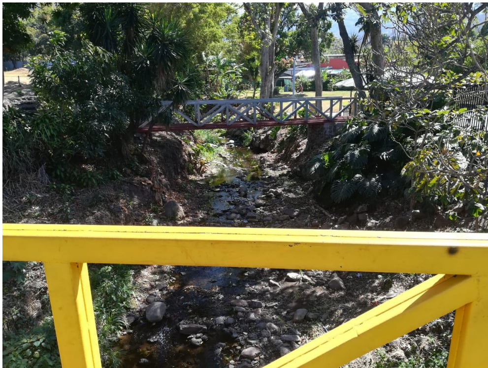
Figura 2.14. Puente 5a, Paso peatonal en propiedad privada, cercanías de Avenida 2
