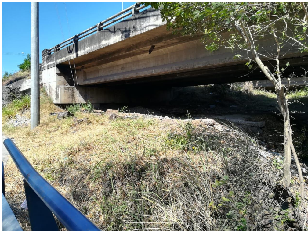
Figura 2.41. Puente 16, Paso vehicular Ruta 27
