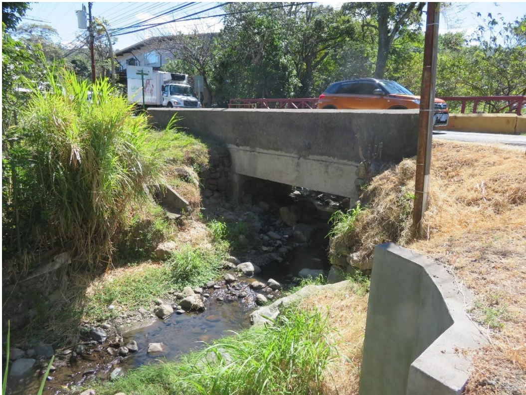
Figura 2.27. Puente 9, Paso Vehicular Avenida 3
