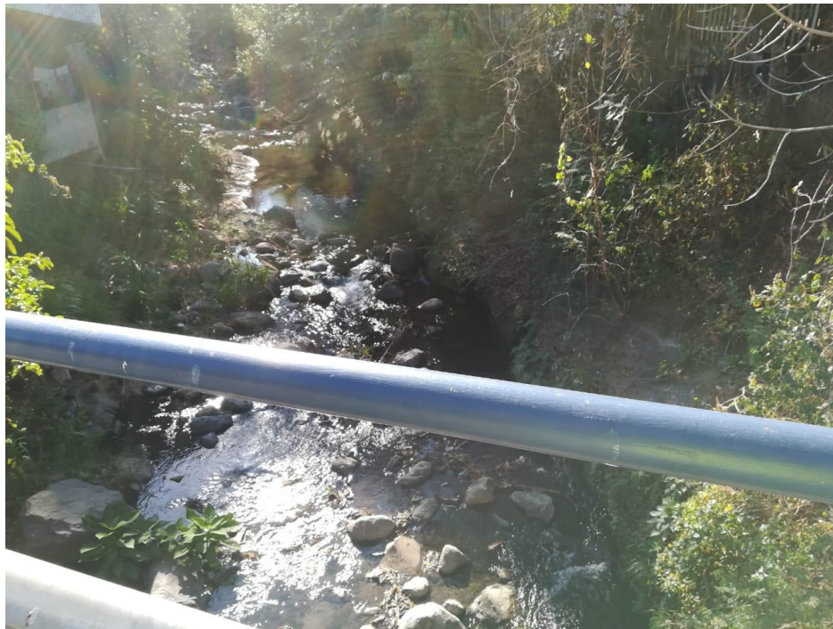
Figura 2.40. Condición del cauce del río Corrogres en el sitio del puente 15
