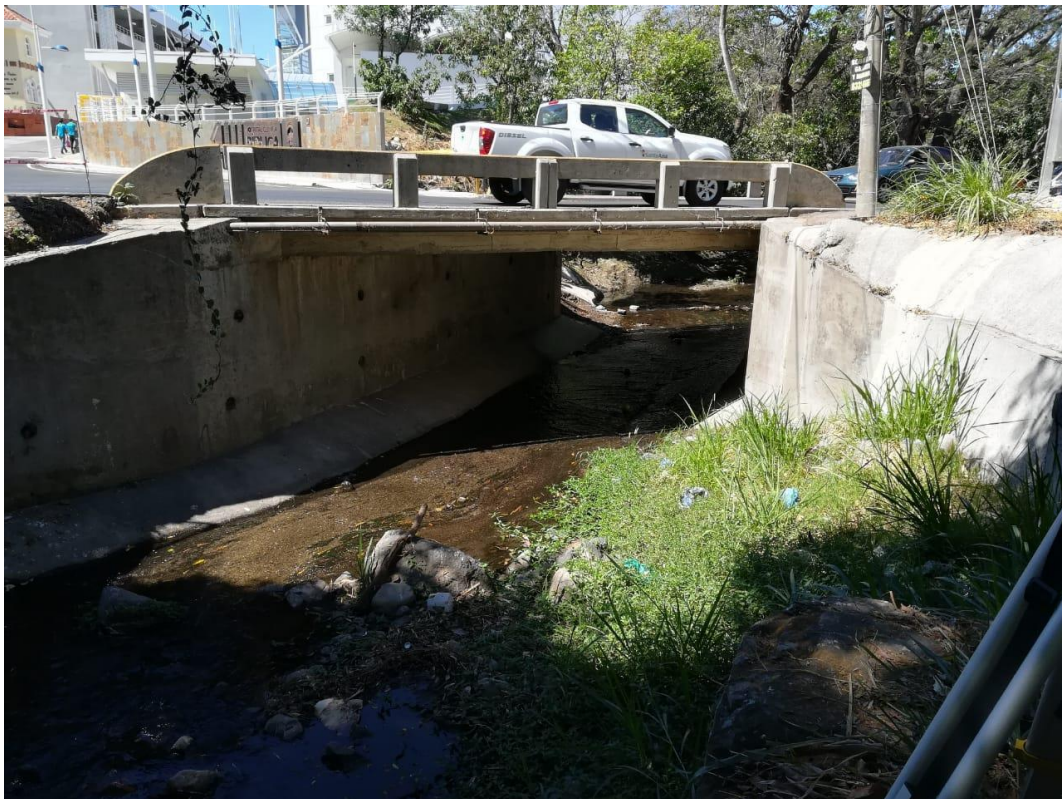
Figura 2.42. Puente 17, Paso vehicular cercanías Clínica Bíblica
