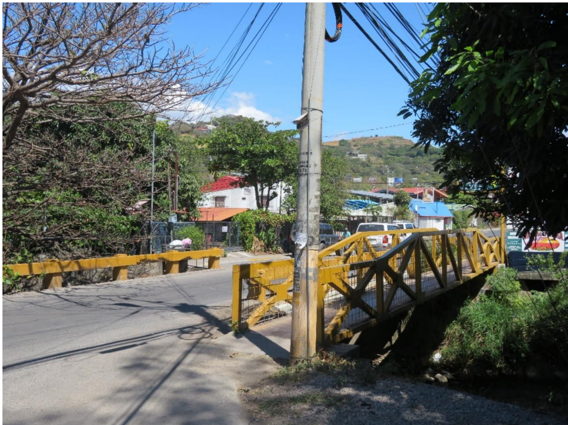
Figura 2.33. Puente 12, Paso vehicular Avenida 23, Calle Gavilanes, La Soya
