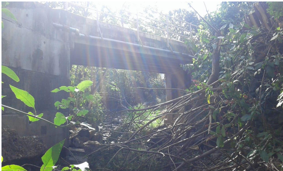
Figura 2.30. Condición del cauce del río Corrogres en el sitio del puente 10
