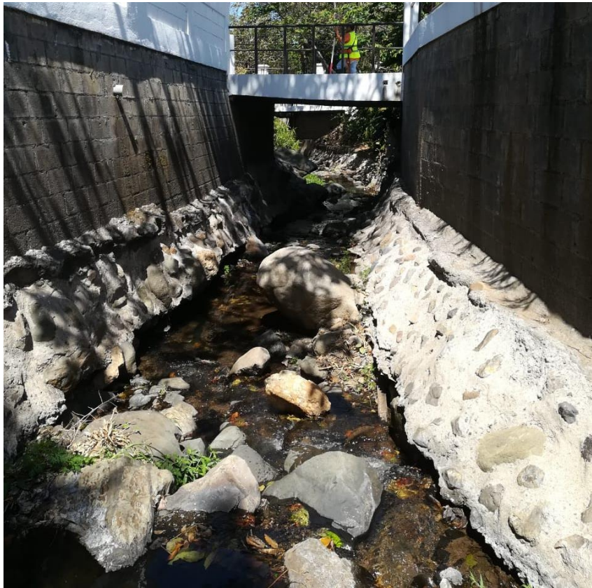
Figura 2.24. Condición del cauce del río Corrogres en el sitio del puente 8a
