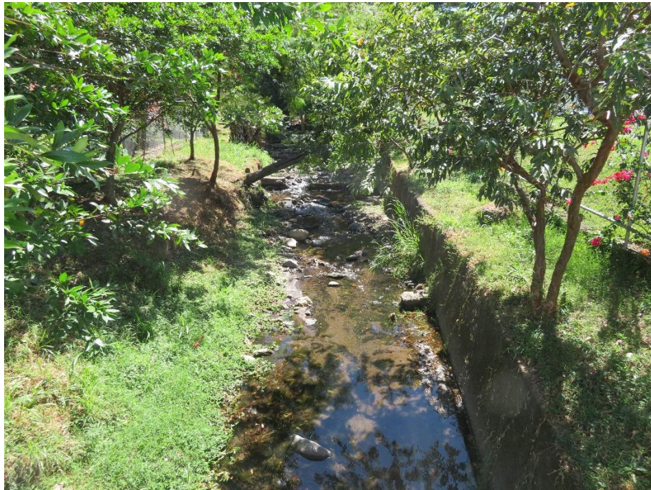
Figura 2.32. Condición del cauce del río Corrogres en el sitio del puente 11
