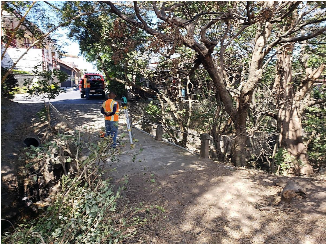
Figura 2.35. Puente 13, Paso vehicular Calle Los González
