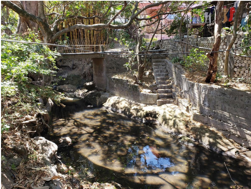
Figura 2.34 (cont.). Puente 13, Paso vehicular Calle Los González
