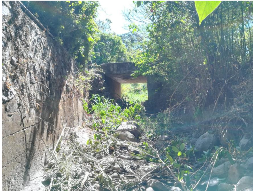
Figura 2.11. Condición del cauce del río Corrogres en el sitio del puente 3
