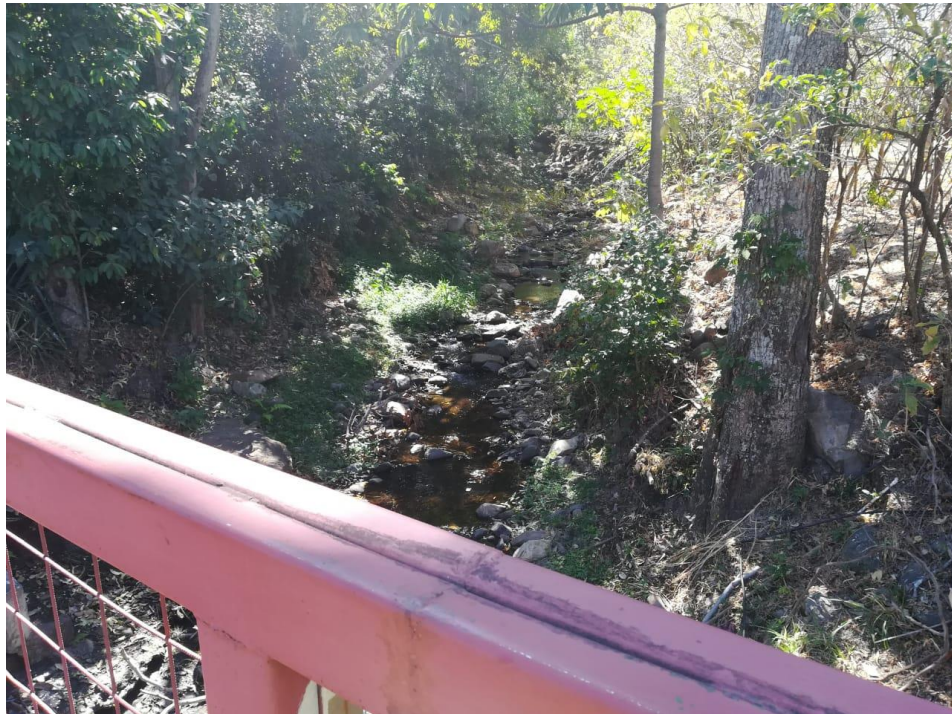
Figura 2.28. Condición del cauce del río Corrogres en el sitio del puente 9
