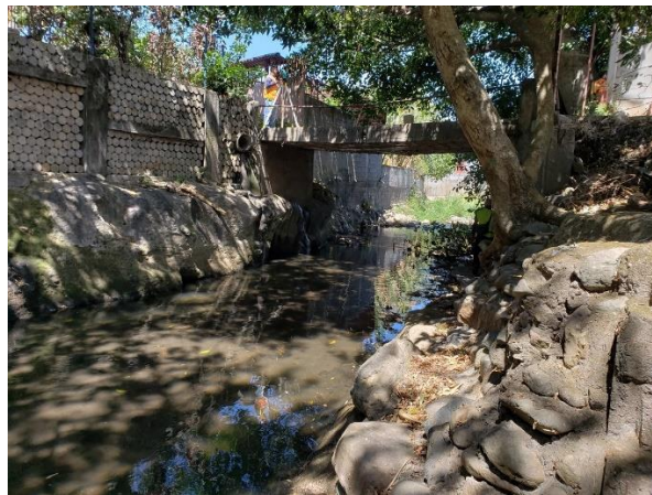
Figura 2.37. Puente 14, Paso vehicular Calle Los Mora
