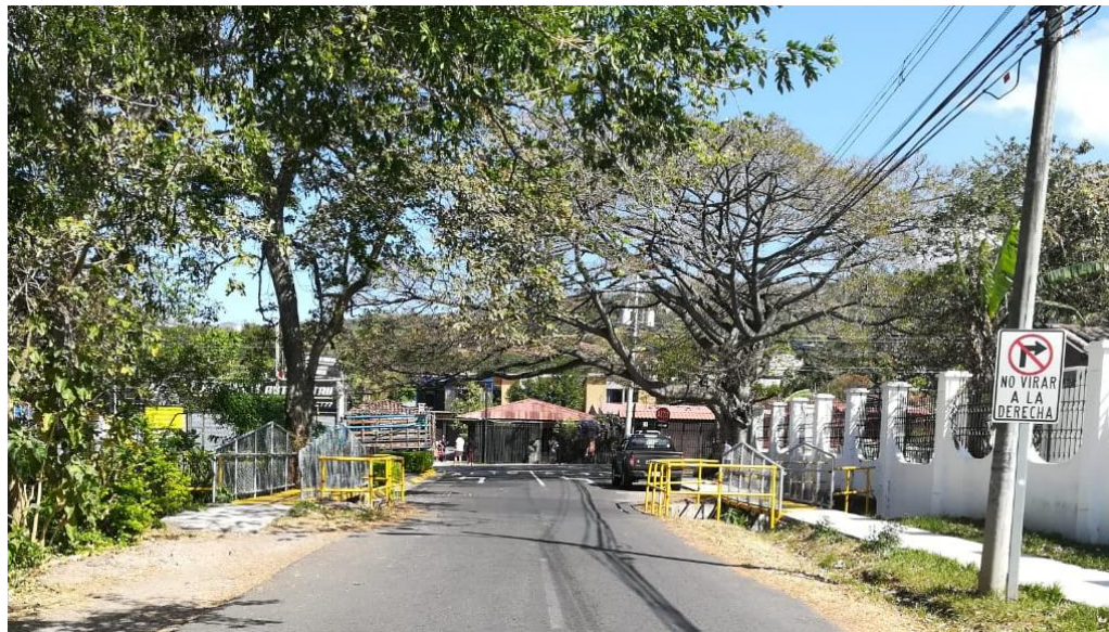
Figura 2.25. Puente 8b, Paso Vehicular Avenida 1
