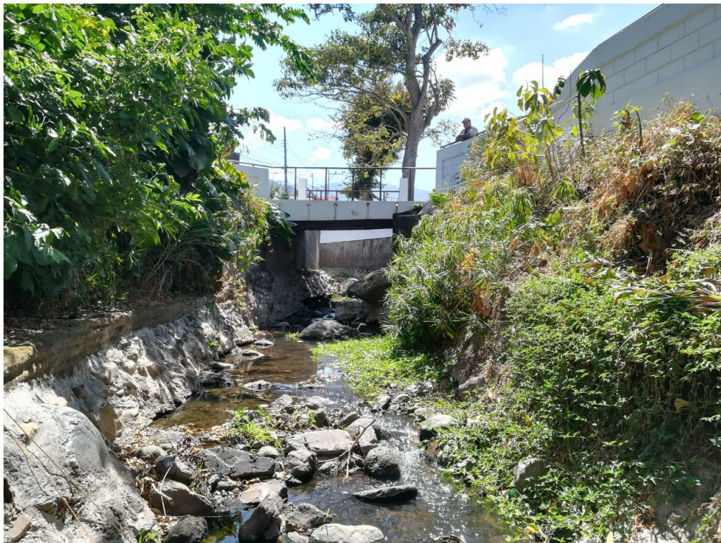
Figura 2.23. Puente 8a, Paso Vehicular Oficentro del Río
