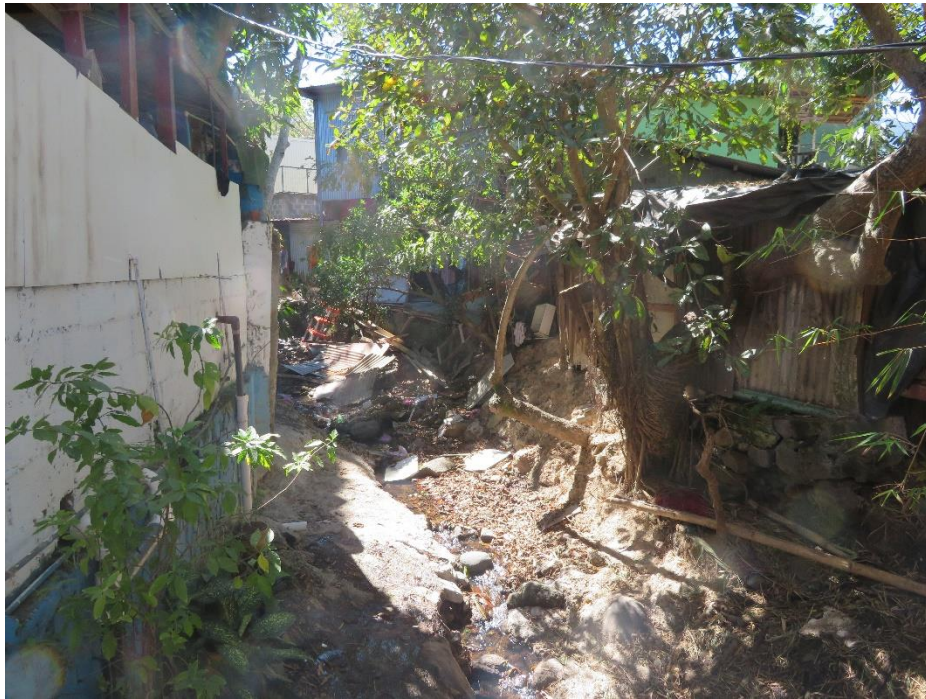
Figura 2.13. Condición del cauce del río Corrogres en el sitio del puente 4
