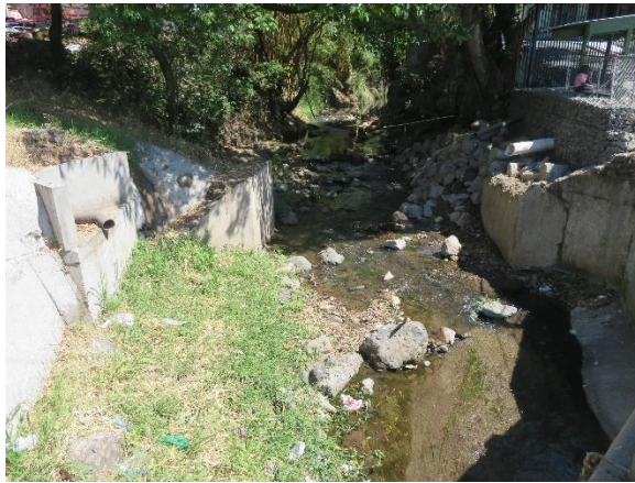
Figura 2.43. Condición del cauce del río Corrogres en el sitio del puente 17
