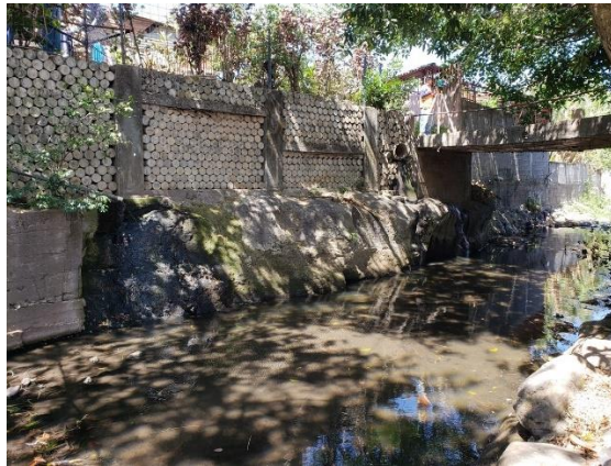
Figura 2.38. Condición del cauce del río Corrogres en el sitio del puente 14
