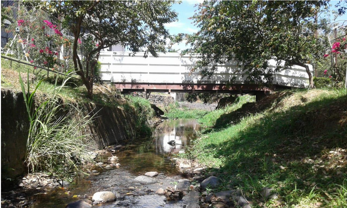
Figura 2.30 (cont.). Puente 11, Paso peatonal interno Condominio Santa Ana Park
