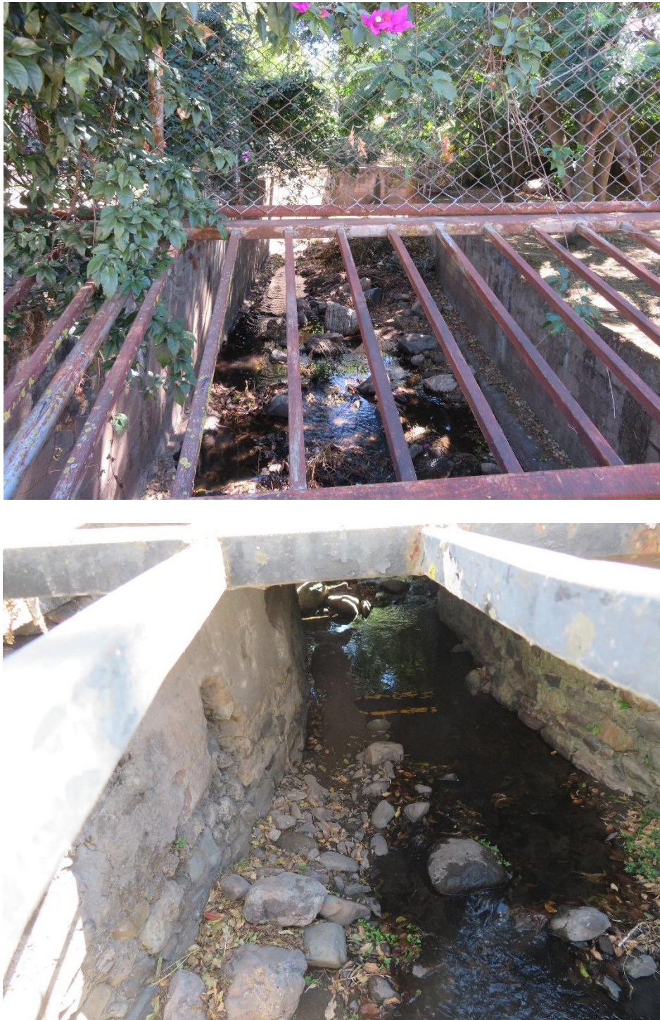
Figura 2.22. Condición del cauce del río Corrogres en el sitio del puente 7
