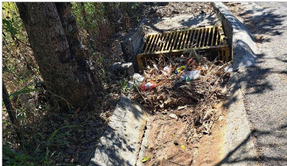
Fotografía 11. Acumulación de sedimentos en los tragantes pluviales de las líneas que desfogan en calle ramal La Cubilla
