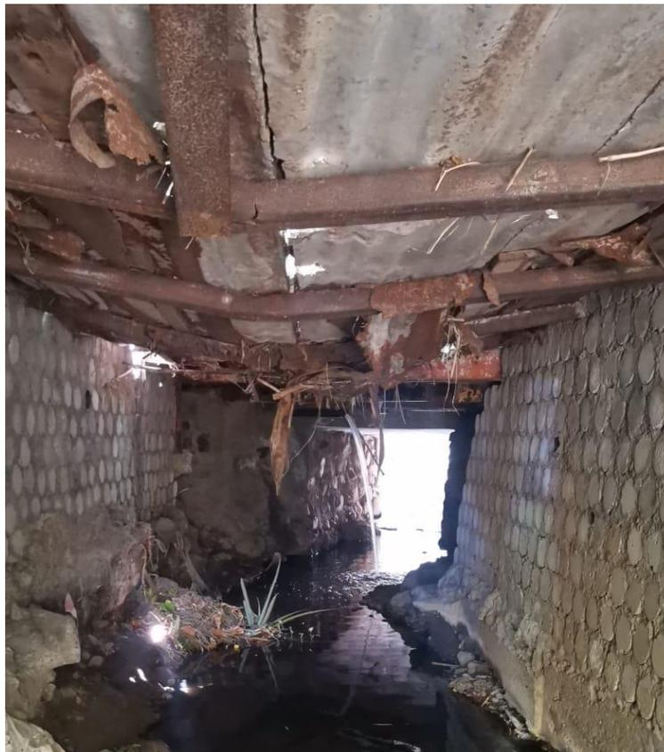
Fotografía 12. Daño estructural en el techo del túnel por el que pasa la quebrada contiguo al parqueo del Hospital Metropolitano
